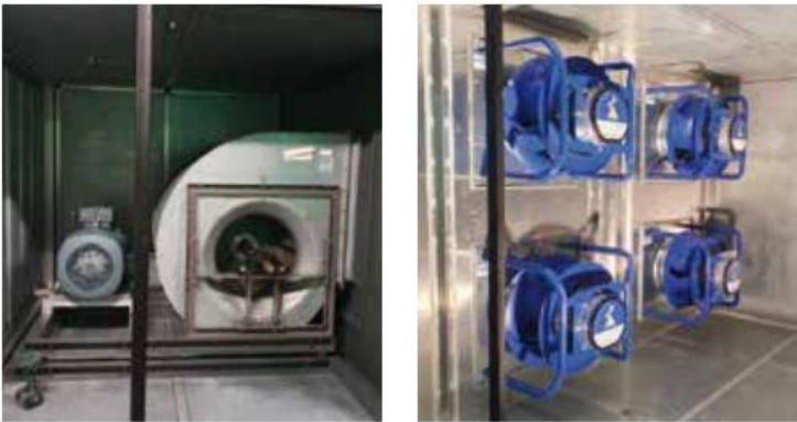
Eine der grossen Umluft-Ventilatoren vor und nach der Erneuerung. Fotos: Lufttechnik AG Wädenswil.
